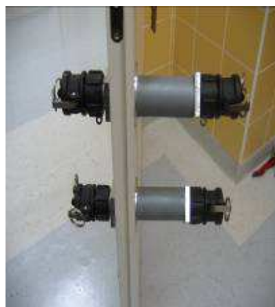
Rys. 3. Widok podłączenia jednostki VHP przez złączki w drzwiach wejściowych
