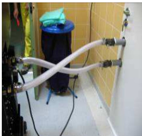
Rys. 3. Widok podłączenia jednostki VHP przez złączki w drzwiach wejściowych
